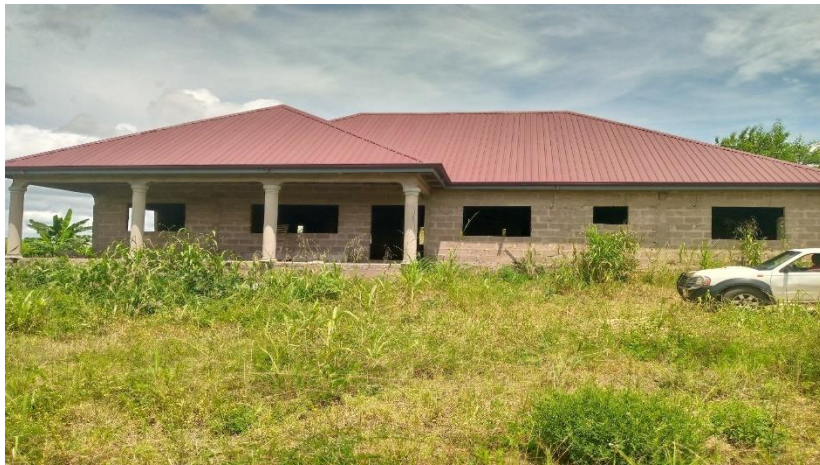
A. Construction of DCE’s Bungalow at Dzolokpuita
